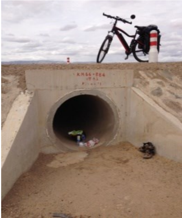
Flash flud Rohre unter der ›Transmongoliana‹
